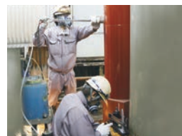
ばい煙(排出ガス)測定
